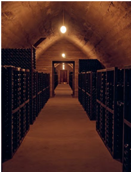
Neuer Weinkeller „Chai“ mit „Baustellenbeton“ aus Stampflehm mit sehr geringen Anteilen an Wasser und weißem Zement. New wine cellar “chai” with “site concrete” made of rammed earth containing very little water and white cement.
