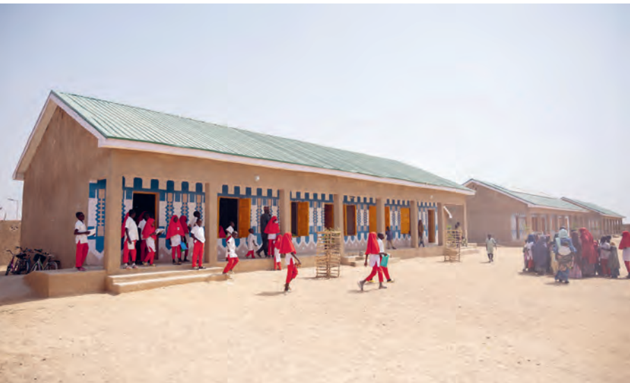
Schule mit kulturellen Farb- und Gestaltungselementen. School with cultural colour and design elements.
