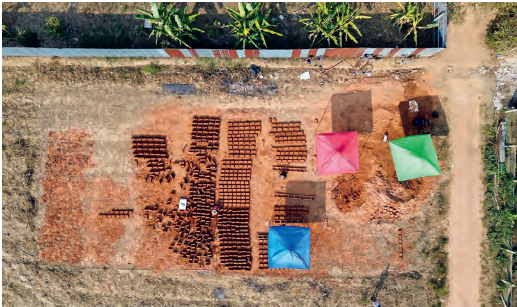
Produktion von 3.800 Lehmziegeln vor Ort. Production of 3800 clay bricks on site.
