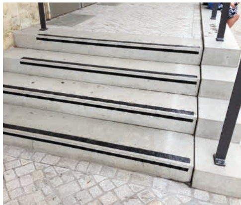
Abb. C 1.32: „Scheinstufeneffekt“ durch nachträglich aufgeklebte Stufenmarkierung
