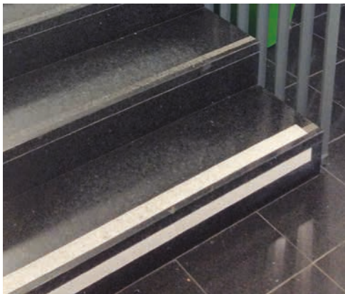
Abb. C 1.31: Nachrüstung einer Stufenmarkierung mit Abstand zur Stufenkante
