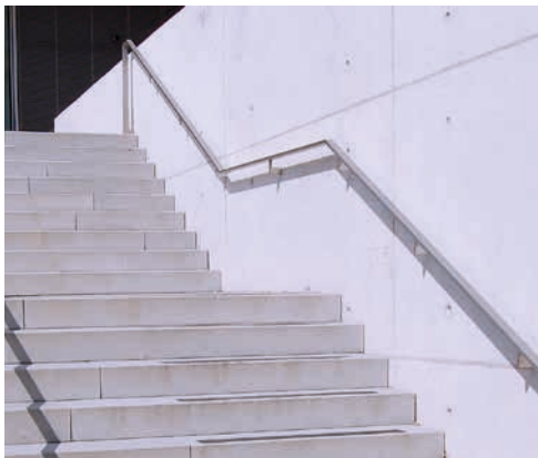
Abb. C 1.36: Betontreppe mit nachträglich aufgeklebter Stufenmarkierung (frontale Ansicht)
