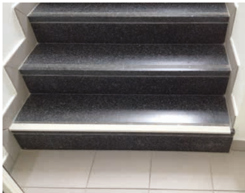
Abb. C 1.34: Nachträgliche Stufenmarkierung mit Kunststoffschiene
