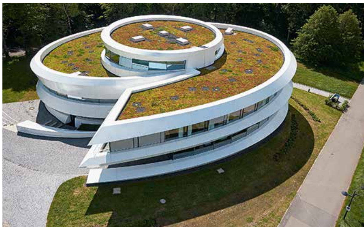
Gelungene Extensiv- begrünung der Firma Bauder auf dem Haus der Astronomie in Heidelberg.
