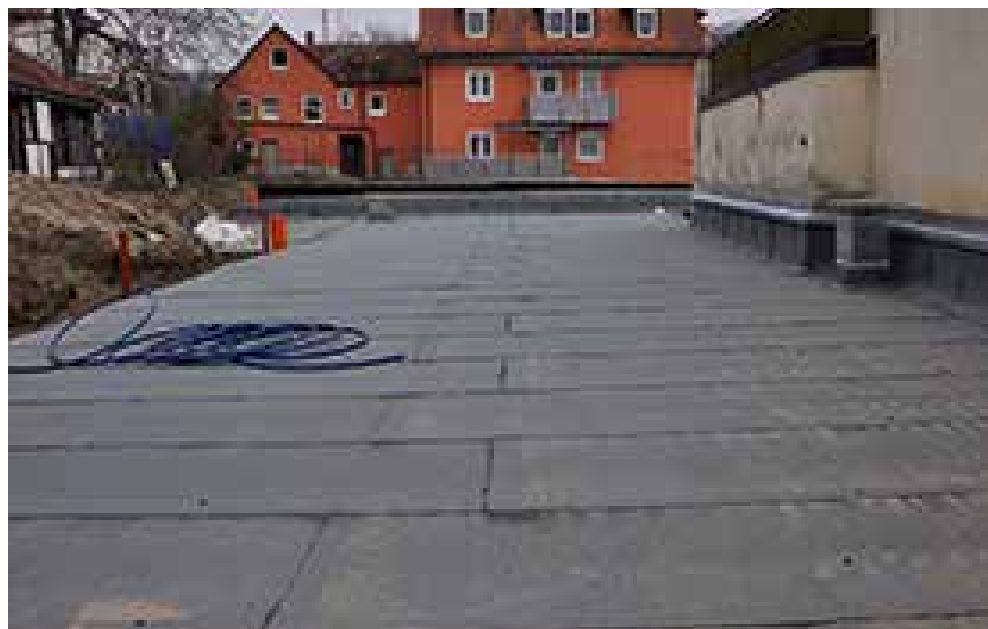
Zweilagige Dachabdichtung mit unterer Lage als Bitumen-schweißbahn, oberer Lage als wurzelfeste Elastomerbitumen-Schweißbahn. Die erhöhten Überlappungen verlaufen mit dem Gefälle und sichern eine gute Entwässerung bei etwa 3 % Gefälle.
