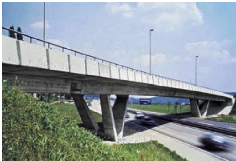
Bild 1-1: Die dynamisch geprüfte, weltweit erste teilweise vorgespannte Leichtbetonbrücke bei Schaffhausen.
