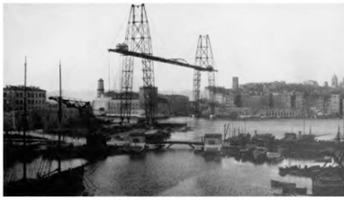
174. ARNODIN. Schwebefähre im «Vieux Port» von Marseille, 1903. Stahlkonstruktion und Steinarbeit harmonisieren gut miteinander.
