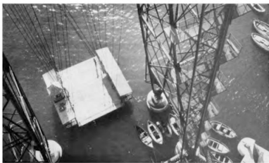
176. ARNODIN. Schwebefähre, Marseille. Blick von der oberen Plattform auf die hängende Fährseil. Beziehung zwischen festen und beweglichen Teilen. Schöne Stahlkonstruktion. Man beachte die Plattformen der in einen Pfeiler einmündenden Treppe, die kühl in den Raum hineinragt (vgl. Bauhausbüchse, 1926, Abb. 262).
