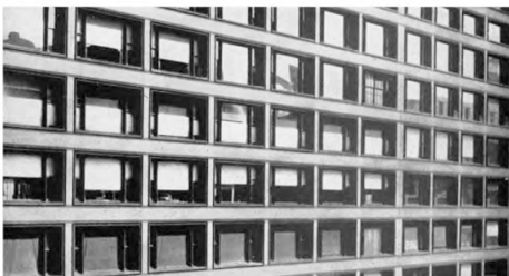
177. LOUIS SULLIVAN. Carson-Pirie-Scott and Company-Warenhaus, Chicago, 1899-1904. Detail. Selbst als Arbeit Sullivans auffallend ob seiner kraftvollen und klaren Gestaltung. Das neutrale und unparteiische Gleichgewicht, das der Skelettkonstruktion eigen ist, wird hier stärker betont als die vertikalen Elemente.
