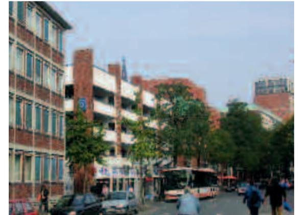
Das bestehende Parkhaus von 1964 wurde in Teilbereichen durch Entkernung und Abtragen der oberen Geschosse zurückgebaut. Ausgangspunkt des Entwurfs ist der Erhalt wesentlicher Teile der alten Bausubstanz bei völlig veränderter Nutzung. So wird der ehemalige Außenraum zum Innenraum, ein nüchterner Zweckbau zum komplexen Raumkunstwerk.
