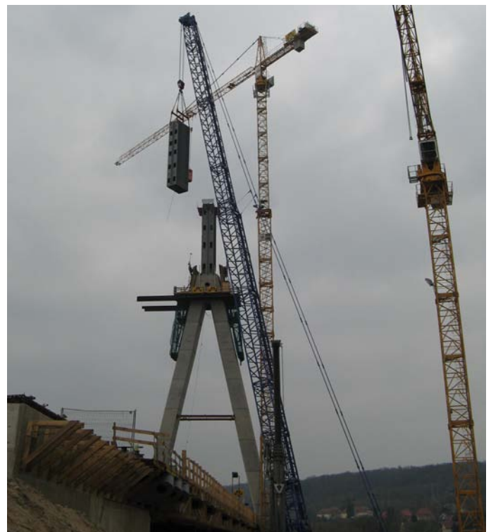
Bild 5.7 Einheben der Stahlkammern
