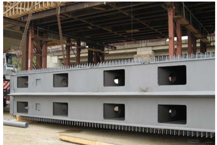
Bild 5.6 Stahlkammern zur Kabelverankerung
