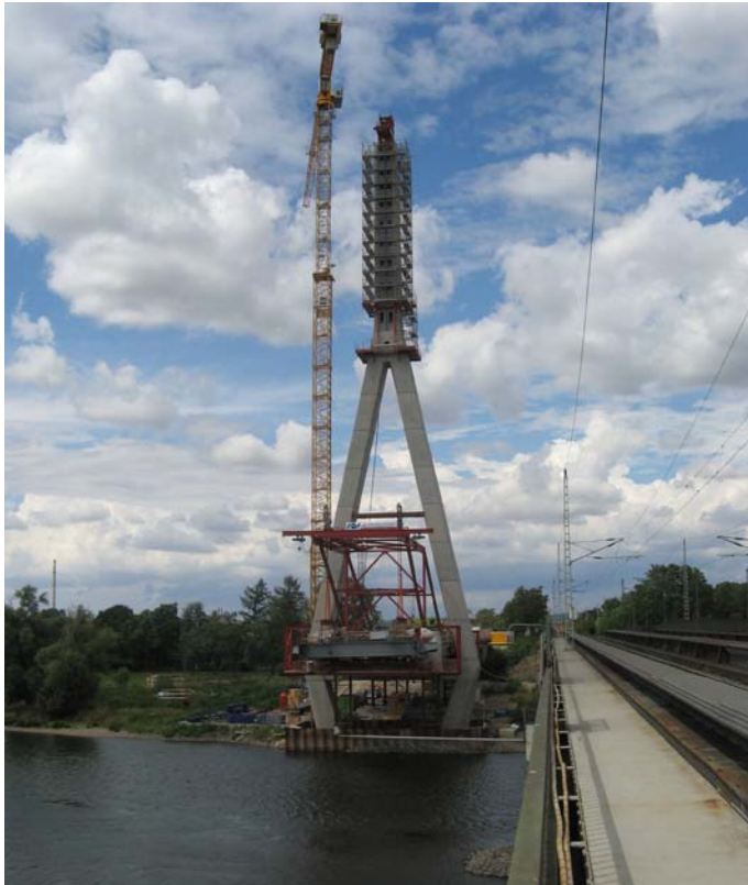
Bild 5.8 Eingerüsteter Pylonkopf
