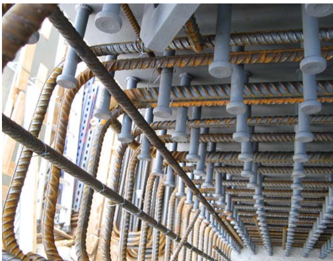
Bild 5.9 Bewehrung der Betonseiten an den Stahlkammern
