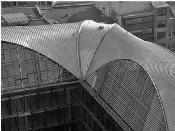
**Bild 5-97** Mehrfach gekrümmter zweischaliger wärmedämmter Dachaufbau
