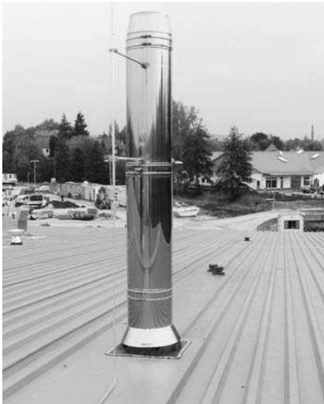
**Bild 5-36** Dichtmanschette auf Schleppblech an einer Rohrdurchführung
