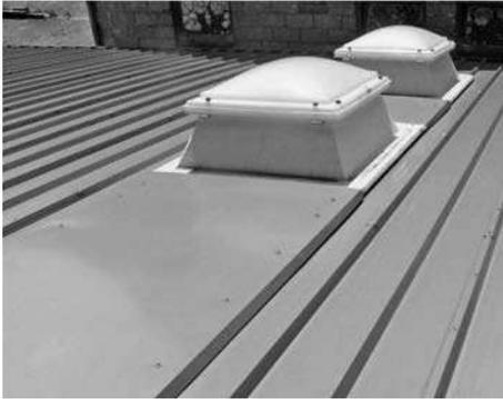
**Bild 5-41** Aufsatzkranz mit ebenen Flanschen und Schleppblech auf Trapezprofildeckung
