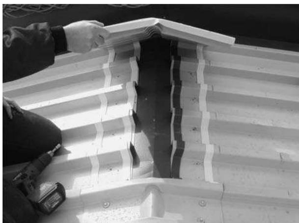
**Bild 5-31** Firstabdeckung mit profilfolgender Kappe
