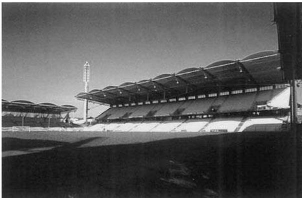
**Bild 5-94** Frei tragende Trapezprofilbögen als Tribünenüberdachung
