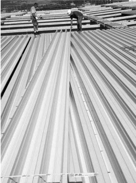
**Bild 5-4** Verlegung von Stahltrapezprofilen als tragende Dachunterschale
