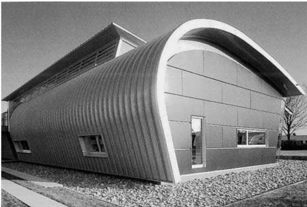
**Bild 5-88** Deckung aus walzgerundeten Aluminium-Stehfalzprofilen
