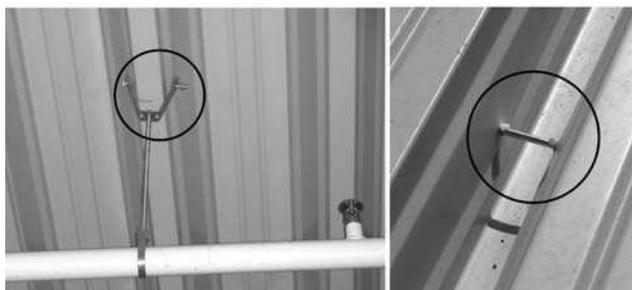
**Bild 5-6** Abhängung von Zusatzlasten an Stahltrapezprofilen – unten links: Blick von unten, unten rechts: Blick von oben
