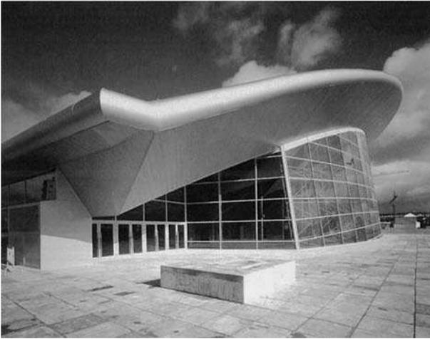
**Bild 5-95** In unterschiedlicher Form walzgerundete Deckungen aus Aluminium-Stehfalzprofilen
