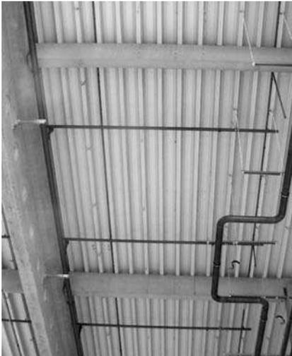
**Bild 5-2a** Trapezprofile als frei von Binder zu Binder tragende Dachunterschale
