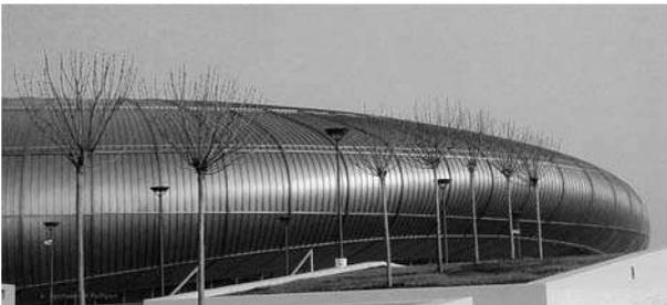
**Bild 5-96** Deckung aus konisch verlaufenden walzgerundeten Aluminium-Stehfalzprofilen
